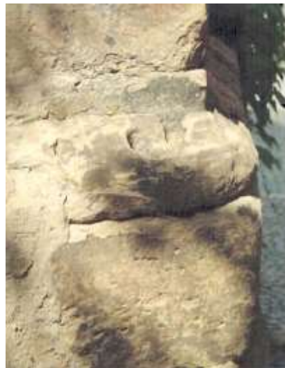
Abbildung 10: Sockelvorsprung an der Südostecke mit näpfchenartigen Vertiefungen Foto: Elmar Altwasser (IBD)
