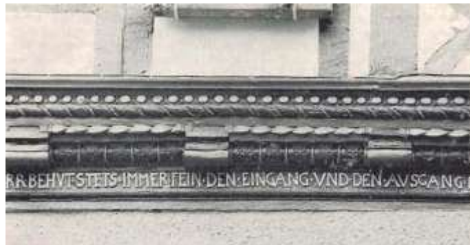
Reichtum an Schnitzwerk und Farben an Rähm, Füllhölzern und Schwelle, Inschrift mit erhabenen Buchstaben
