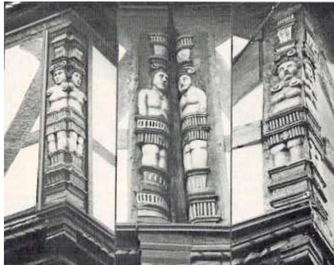
Geschnitzte Eckpfosten im 2. OG
