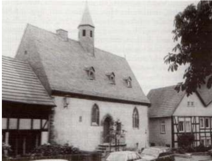
Das Beinhaus nach der Sanierung (Repro GFA) © Rudi-Kaus
