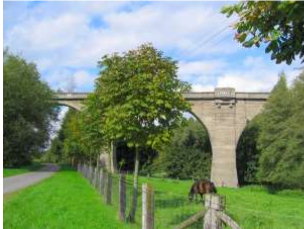
Das Eifaer Viadukt © GFA
