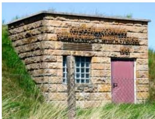
Gruppenwasserwerk Schwabenrod-Münch-Leusel 1961 - © GFA
