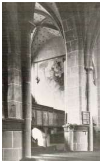
Abb. 4: Nördlicher Arkadenpfeiler mit Seitenschiff Foto: Meyer-Barkhausen
