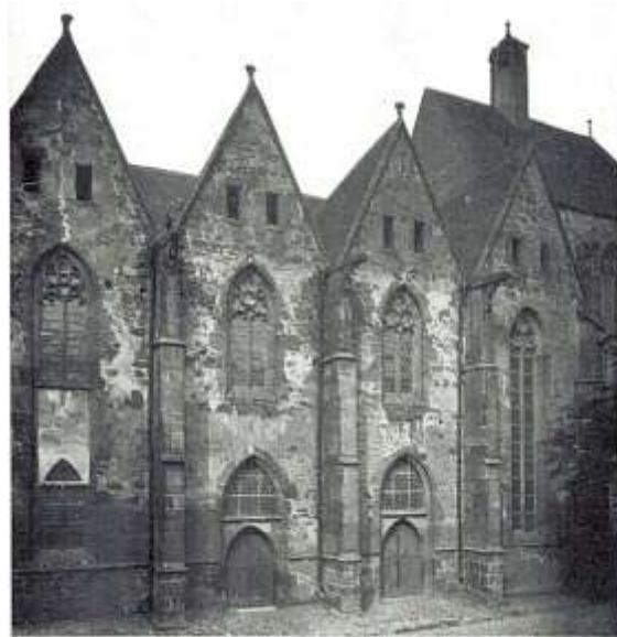
Abb. 21: Alsfeld, Walpurgiskirche. Außenansicht von S. Aufnahmen: Eichell (vor 1900, Archibild des Landes-konservators).
