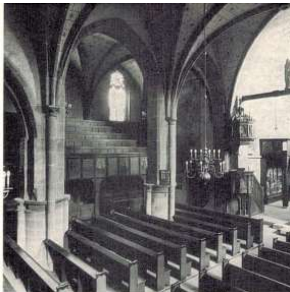
Abb. 1: Asfeld, Walpurgiskirche, Innensicht nach SW.
